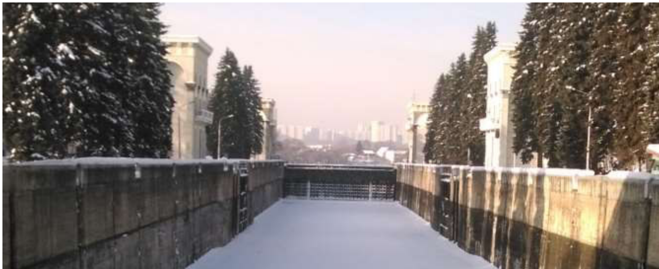
Фото 1.3.1 Вид на камеру шлюза, промежуточную и верхнюю головы
