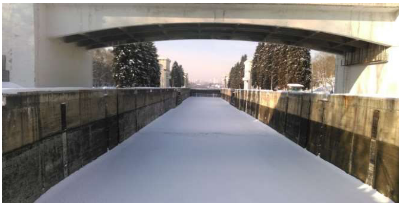
Фото 1.3.3 Вид на камеру шлюза
